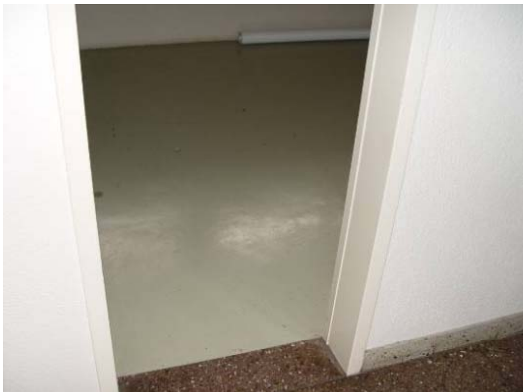
Foto: Eksempel på gulvmaling fra enfamiliehuse i Schweiz. Den viste gulvmaling oplyses, at indholde 19.000 mg/kg (1,9 %) PCB (foto: Urs Wagner).
