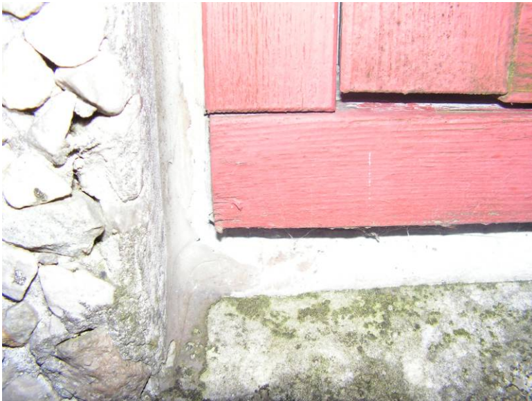
Foto: Eksempel på fugemasse anvendt omkring et vindue i en betonelementfacade.
